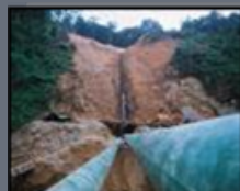
Construcción de Ductos para Transporte de : Crudo, Combustible, Gas y Agua
