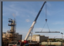
Montaje de tuberías
