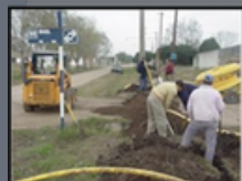
Construcción de Líneas de Distribución Domiciliaria de Gas y Agua.
