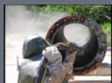
Sand-blasting y Aplicación de Pinturas Industriales
