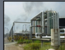
Aislamiento de Tuberías y Equipos.
